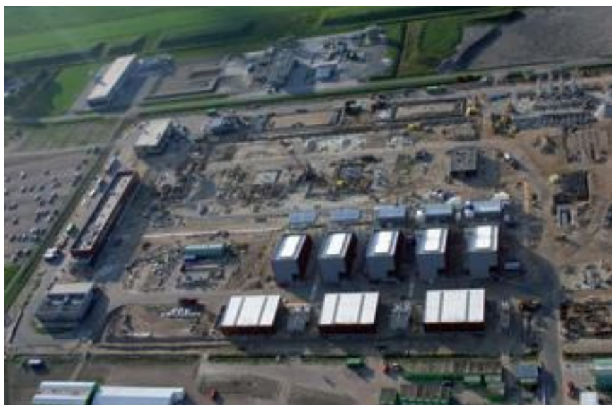
Aardgasbuffer Zuidwending vanuit de lucht gezien.
